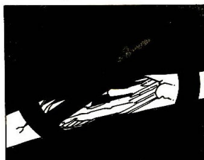
— câble électrique endommagé
